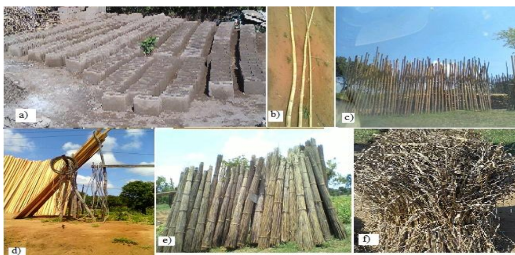
Fig. 2: Svitirhu sva vuyaki (Material usado para a construção das palhotas)
